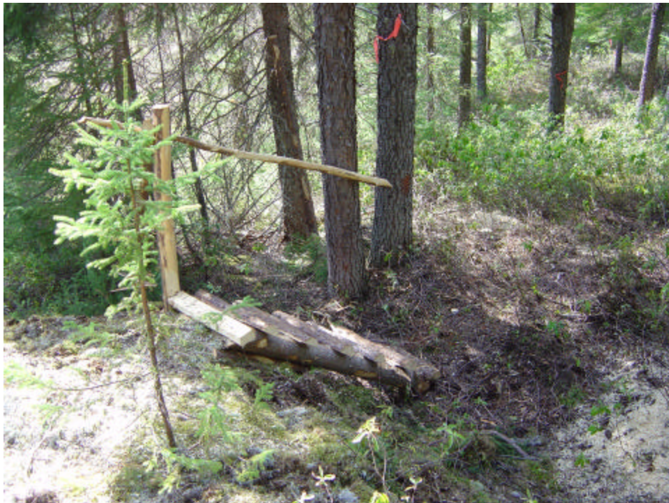
Figure 8: Exemple d'escalier aménagé
