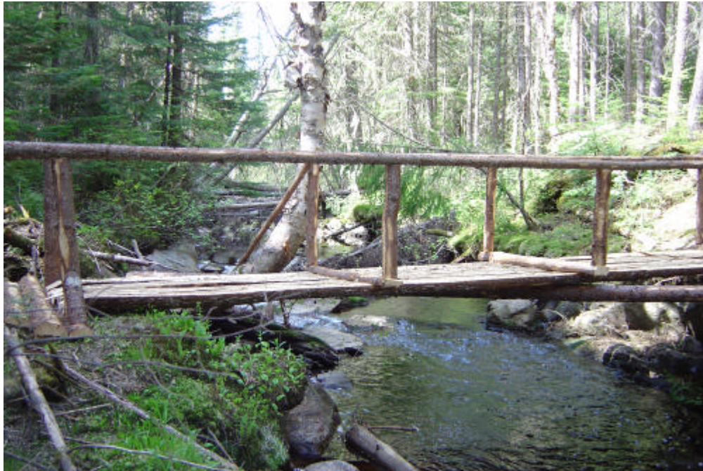
Figure 4: Le pont reliant les deux rives de la rivière Phiran (vue de côté)
